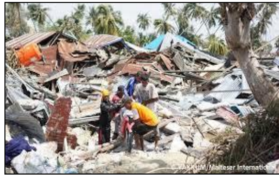
Photo.7 : Séisme (2018) en Indonésie) ( malteser-international.org )
